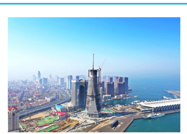
近日，中建八局青岛公司山东港口大厦项目屋面钢结构施工顺利完成，项目建设进入内部机电安装和装饰装修的关键时期。
